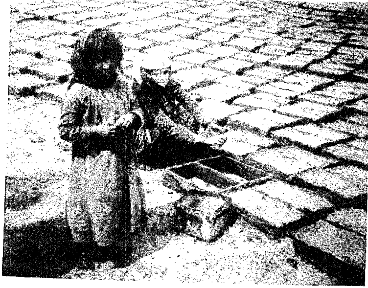
الشكل رقم ٧٢: في قرى العراق مازالوا يصنعون القرميد من الطين المعالج بالقش والمصبوب بقالب خشبي بدون قعر. يتم صقل السطح والتجفيف في أشعة الشمس.
